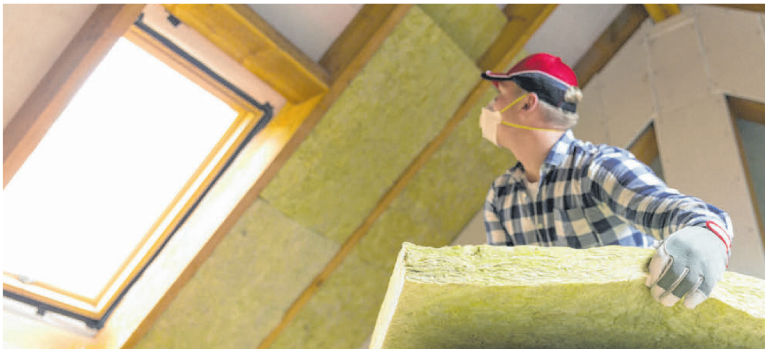
Durch eine Dachdämmung können fünf- bis siebenfach bessere Wärmewerte erzielt werden.
