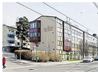
Sanierung des Gemeindebaus in 1140 Wien mit innovativer Fassade
