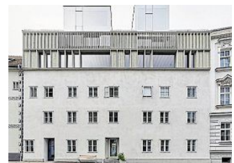
Das Stadthaus Linz wurde von mia2 Architektur saniert und erweitert
