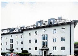
Die Neue Heimat Tirol sanierte die „Franzosen Häuser“ in Innsbruck
