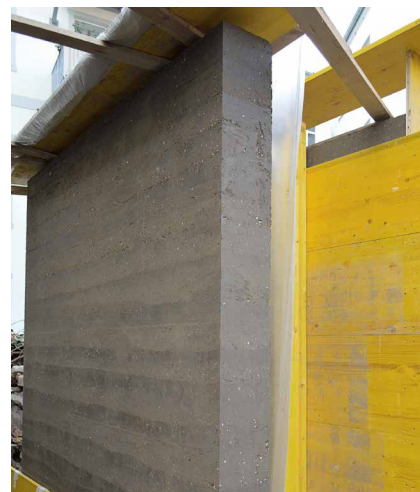
Abb. 13: Die Stampflehmwände aus dem Material des Aushubs mussten 3 Jahre im Hof ausharren, bis sie zum Einsatz kamen
