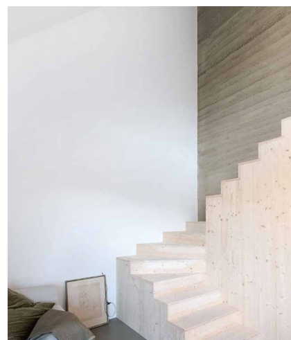
Abb. 14: Die Stampflehmwandfertigteile wurden im 4. Obergeschoss sowie der Empore eingebaut und tragen den First
