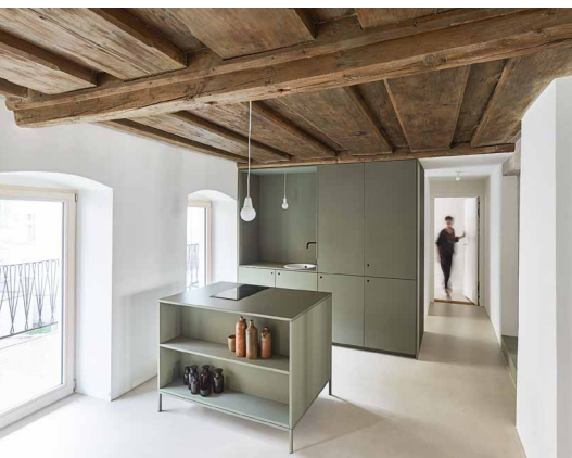
Abb. 10: (Wohn-)Küche in einem sanierten Geschoss. Die historische Holzdecke wurde mittels Holz-Beton-Verbundtechnik erhalten und ertüchtigt.
