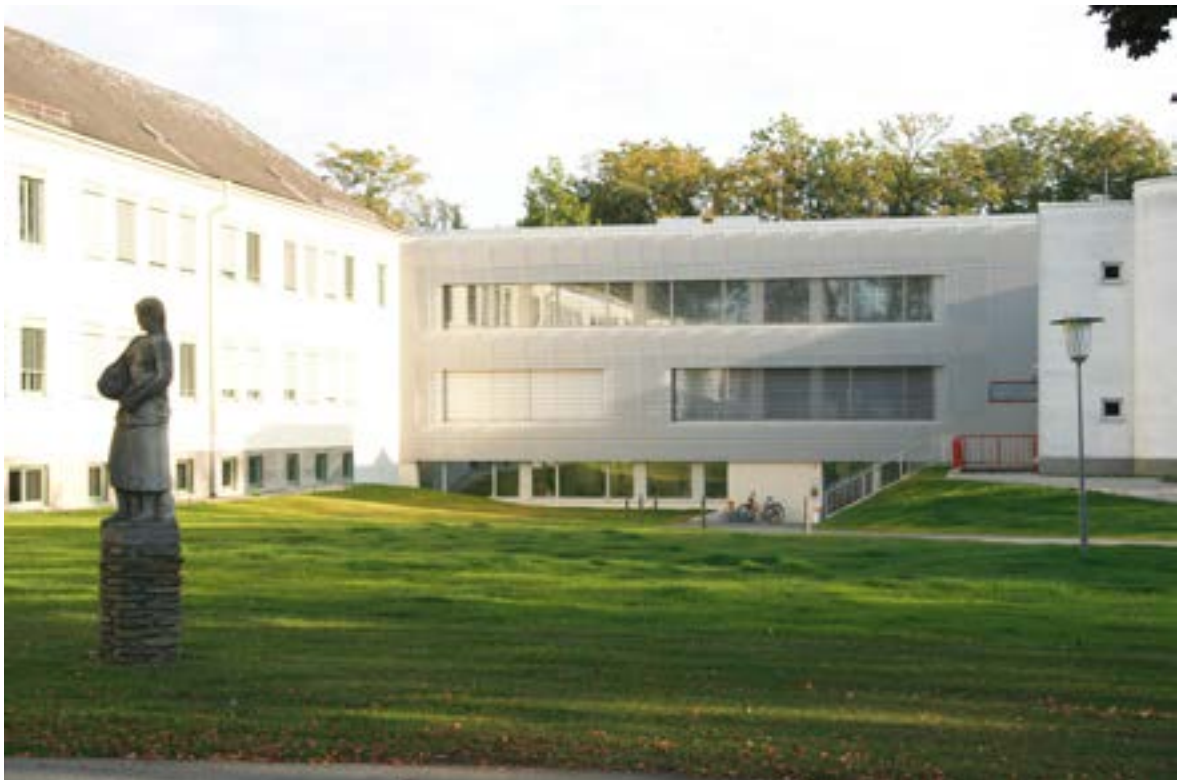
Volksschule Kirchberg am Wagram: Sieger ETHOUSE Award 2012 „Öffentliche Bauten“; Architektur: ah3 Architekten ZT GmbH; Verarbeitung: Alpine Bau GmbH Foto: Martin Wagensohner
