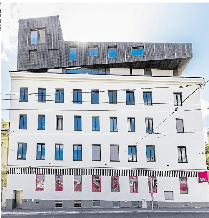
Die Sanierung eines desolaten Gründerzeithauses im Wiener Gemeindebezirk Favoriten ist eines der zehn nominierten Projekte für den ETHOUSE Award
