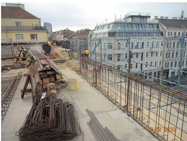
Abb. 17: Errichtung der dreigeschossigen Dachaufstockung in Stahlbeton (4. OG) ...
