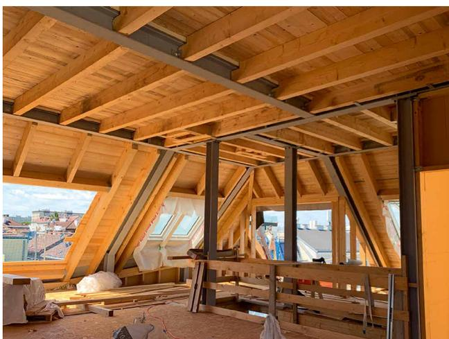
Abb. 19: 2. DG in Stahl und Holz [© Ulreich Baurträger GmbH]
