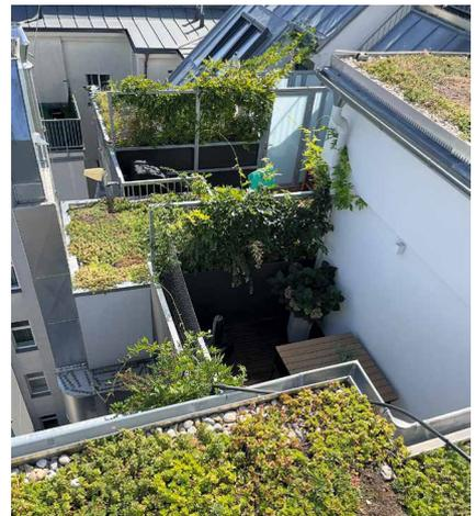
Abb. 16: Begrünung auf den Dachaufbauten [© Ulreich Baurträger GmbH]
