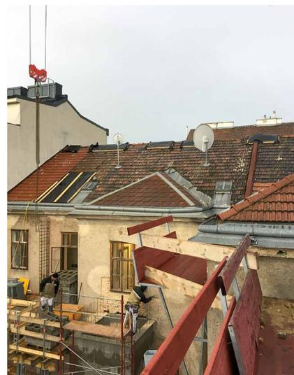
Abb. 10: Abtrag des maroden Dachstuhls [© Ulreich Baurträger GmbH]
