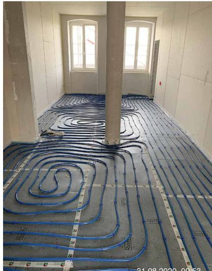
Abb. 26: ... alle Heizungen durch Zentralheizungen mit Fernwärmeanschluss ersetzt und ... [© Ulreich Bauträger GmbH]
