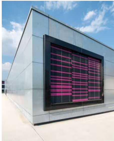
Die komplette Erneuerung der Fassade erfolgte mit feuerverzinkten Stahlplatten
