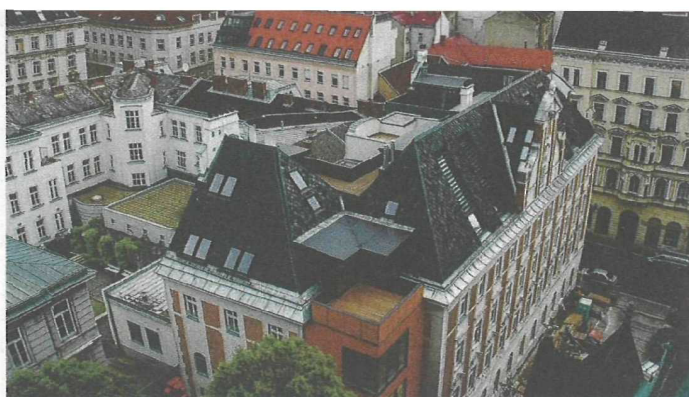
In der Kategorie Wohnbau wurde ein unter Denkmalschutz stehendes Projekt lobend erwähnt. Kronreif_Trimmel & Partner sanierten ein ehemaliges Kloster in der Kaiserstraße in Wien
