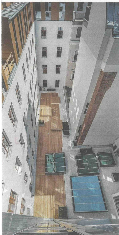
Dieser Dachausbau am Wiener Schottenring von Rüdiger Lainer + Partner Architekten wurde in der Kategorie „Gewerbliche Bauten“ lobend erwähnt
