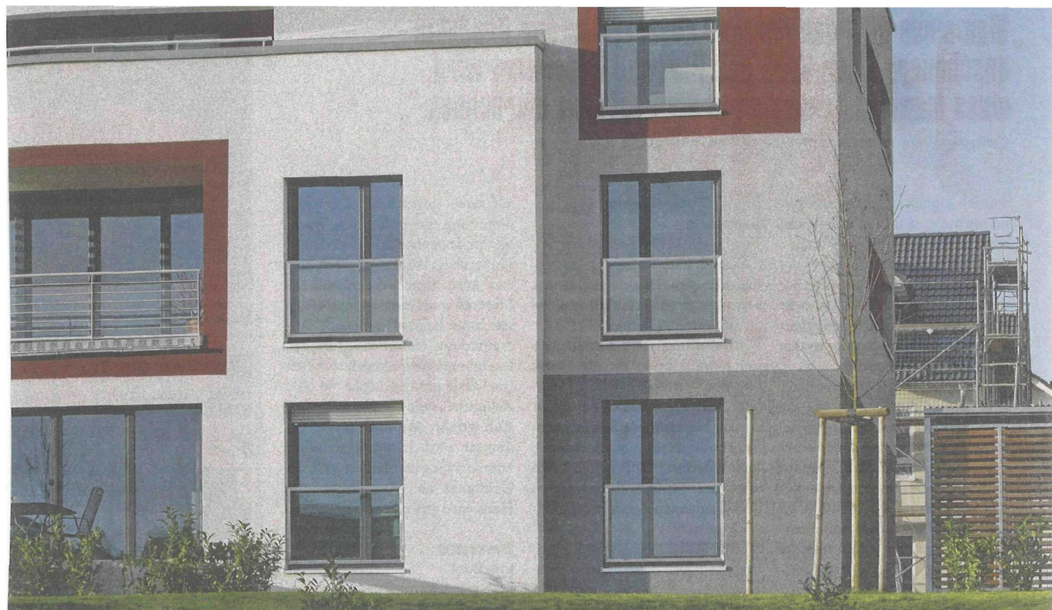
Korkplatten? Von außen ist nicht erkennbar, womit ein Haus gedämmt wurde
